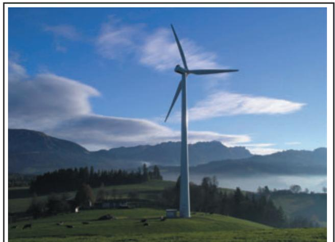
**Abb. 11: Windkraft: Die Leistung einer modernen Anlage beträgt etwa 2 Megawatt (= Versorgung von bis zu 2.000 Haushalten im Jahr mit Energie). An günstigen Standorten (bei ca. 1,5 MW) können in 20 Betriebsjahren rund 76 Mio. kWh Strom erzeugt werden (= Verbrennung von ca. 84.000 t Braunkohle), Quelle: <http://www.tourismus-entlebuch.ch/Bilder/Windkraftanlage.jpg>.**
