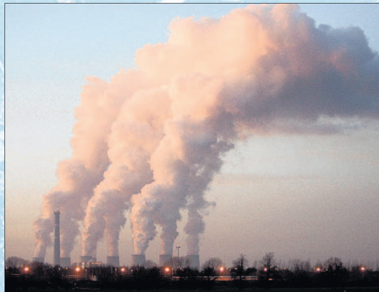
Die Kühltürme des Braunkohlekraftwerkes Jämschwalde stoßen massiv Wasserdampf aus. Auch der ist ein Klimakiller. Foto: ddp
