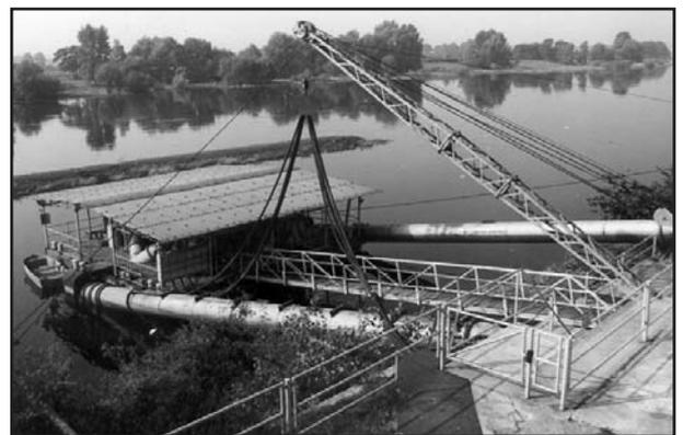
Abb. 42: Endmontage der schwimmenden Pumpstation Grödel bei Riesa an der Elbe für die Beregnung von 5,2 Tha (Foto: D. Fickert)
