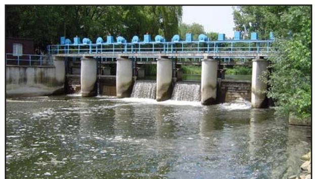
Abb. 33: Schützentafelwehr in Egeln zur Speisung des Mühlengrabens mit der Beregnungspumpstation Westeregeln (Foto: M. Simon)
