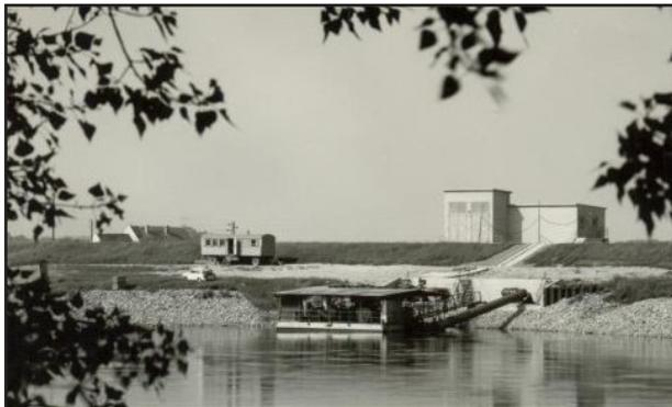
Abb. 44: Schwimmende Pumpstation am Standort Mehderitzsch für die Beregnung von 5 040 ha
