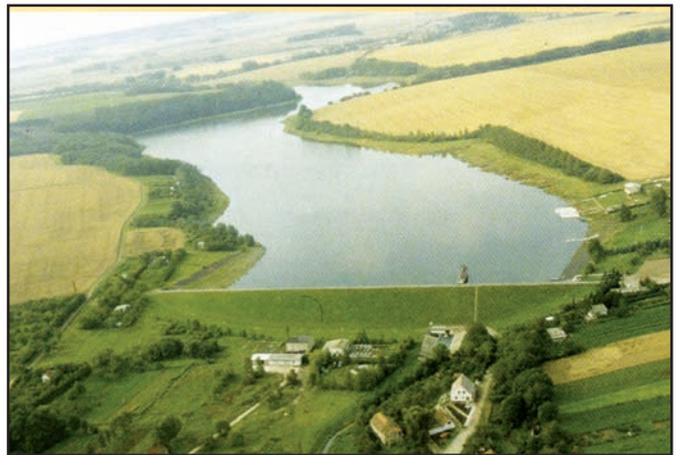
Abb. 11: Wasserwirtschaftlicher Speicher Großbrennbach für Beregnungswasser mit einem Stauraum von 2,82 Mio. m<sup>3</sup> (Foto: H. Deubner)
