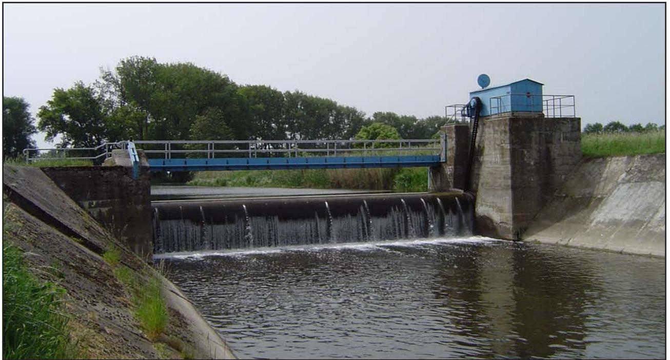
Abb. 15: Walzenwehranlage in der Bode bei Hadmersleben – ermöglichte die Wasserbereitstellung für die Beregnungspumpstationen bei Andersleben (3 806 ha) und am Mühlengraben bei Hadmersleben (1 562 ha - Foto: M. Simon)
