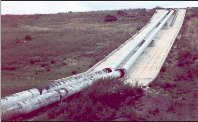
Abb. 13: Rohrleitung von der Pumpstation Elbeabstiegskanal bei Magdeburg zur Überleitung von Elbewasser in den Mittellandkanal für 6 187 ha Beregnungsfläche im Einzugsgebiet der Ohre entlang des Kanals (Foto: Archiv LHW Magdeburg)
