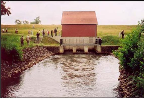
Abb. 58: Luftseitiges Schieberhaus des neuen Entnahmebauwerks bei Reitwein/Oder
