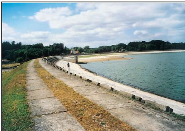
Abb. 54: Hauptdamm des Dossespeichers Kyritz mit Entnahmebauwerk (Foto: M. Simon)
