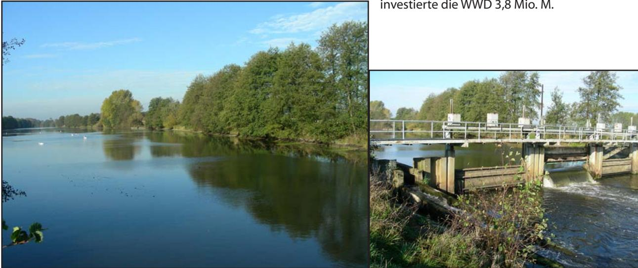
Abb 24: Wehranlage in der Biese bei Schliecksdorf mit 250 Tm<sup>3</sup> Stauraum (Fotos: U. Hahn)
