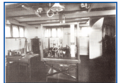
Oben: Registrierraum unterhalb der Turmplattform mit Registrierteil der Windanlage, Foto um 1910
