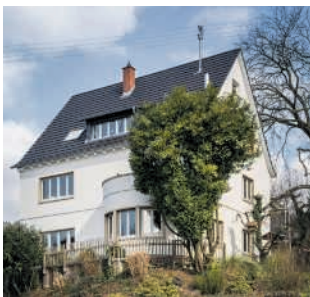
Eine Erdgasheizung mit einer Anschlussleistung von 28 Kilowatt versorgt seit 2014 ein Zweifamilienhaus in Ziegelhausen und produziert rund 34.000 Kilowattstunden Wärme.
