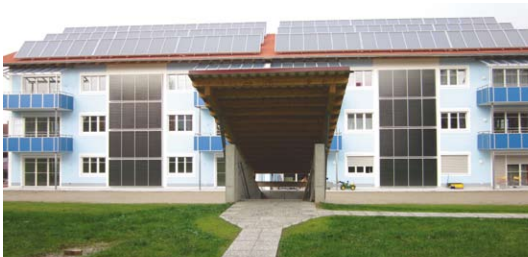
Das Sonnenhaus-Konzept im Mehrfamilienhaus: Bei diesen zwei Mehrfamilienhäusern mit insgesamt zwölf Mietwohnungen sorgen 332 m 2 Solarkollektoren auf den Dächern und an der Fassade für Wärme.
