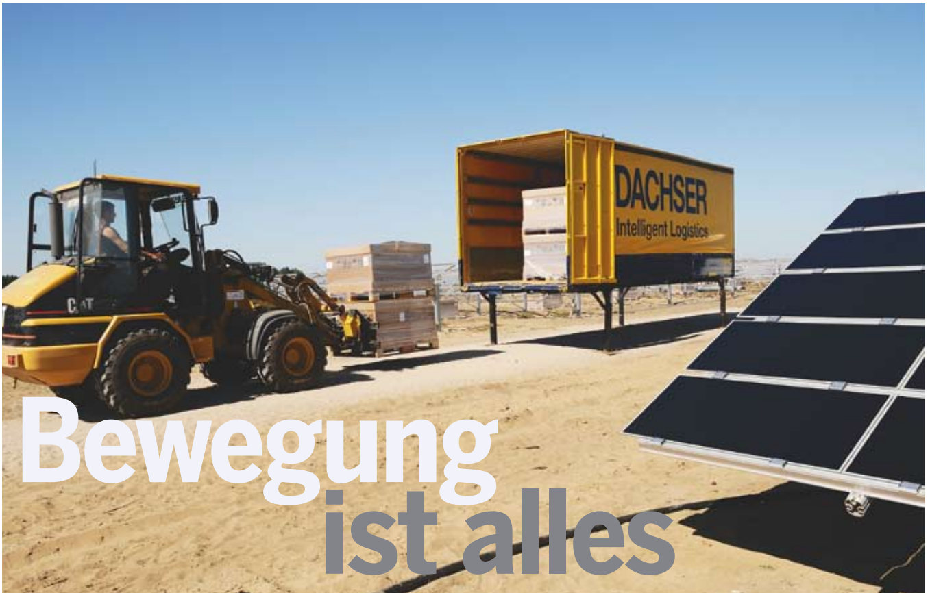
Wechselbrücken werden zu mobilen Lagerflächen: Entladung am Montageplatz.
