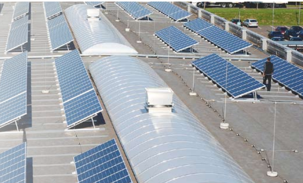
Auf mit der Dachdichtung verschweißten Profilen wurden bei Brohl in Föhren die Module einer 650-kW-Anlage montiert.
