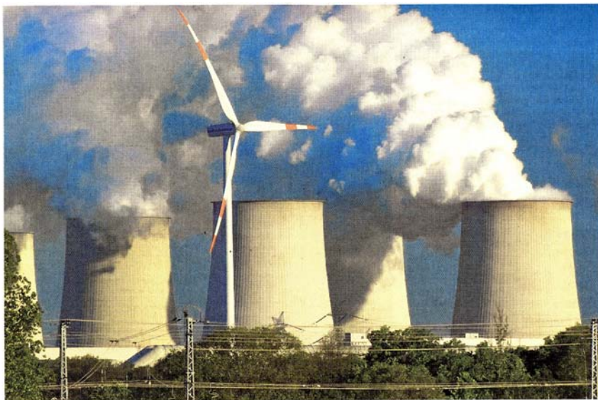
Kohlendioxid wird teuer. Das Braunkohlekraftwerk Jämschwalde muss strenge Klimavorgaben erfüllen.
