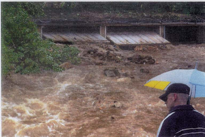
■ Starke Regenfälle im Erzgebirge verwandeln am 12. August die Bundesstraße 169 bei Schneeberg (Sachsen) in einen reißenden Fluss
